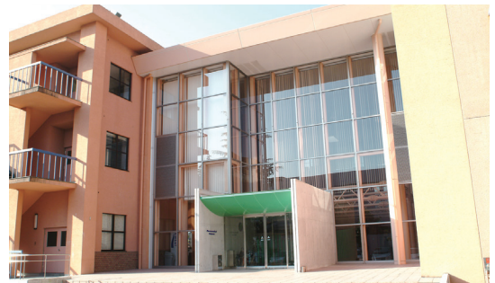
薬学部実験研究棟
